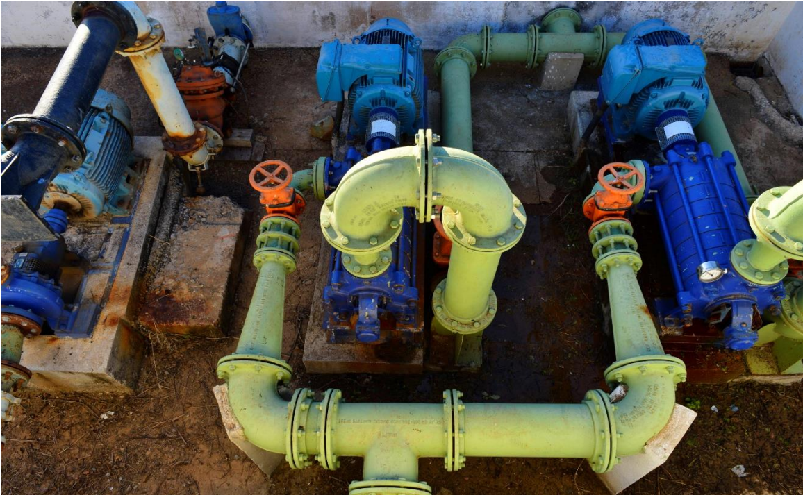
RAMAL NORTE DO SISTEMA ADUTOR DA IBIAPABA – Foto: Cogeh
