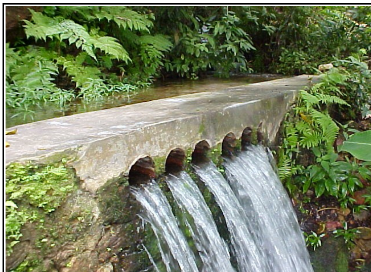
FIGURA 02 – Foto das telhas d’água (instrumento para medição de vazão) utilizadas na cidade do Crato (Cariri) a partir da partilha das águas da Fonte Batateira em 1855 e atualmente ainda em operação. Fonte: Autor principal (2004).
